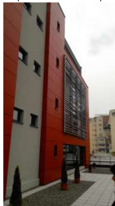
S.C. MULTINVEST S.R.L. - Construire clădire de birouri pentru sprijinirea afacerilor în Municipiul Târgu Mureș, DMI 4.1 POR
